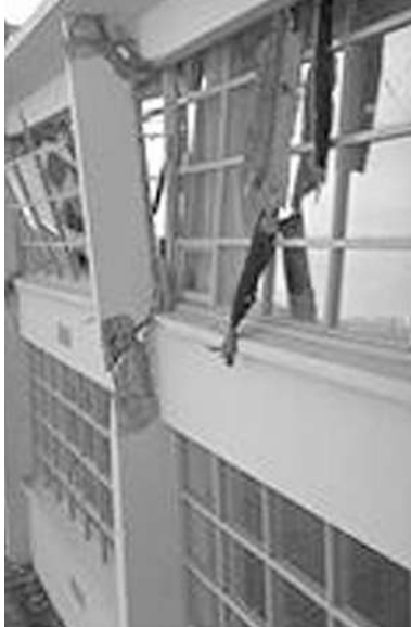
Bild 37: Schwach ausgebildeter Knotenpunkt
