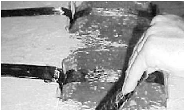
Bild 25: Im Bereich der Betonplatte werden Schlitzte gefräst, damit ein Verankern des S&P C-Sheet 640 in der Druckzone möglich ist.
