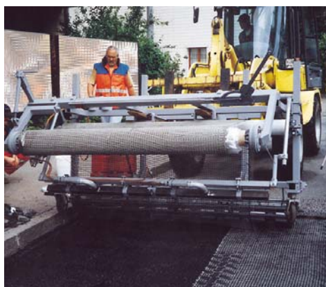
Bild 9: Einbau S&P Carbophalt G
