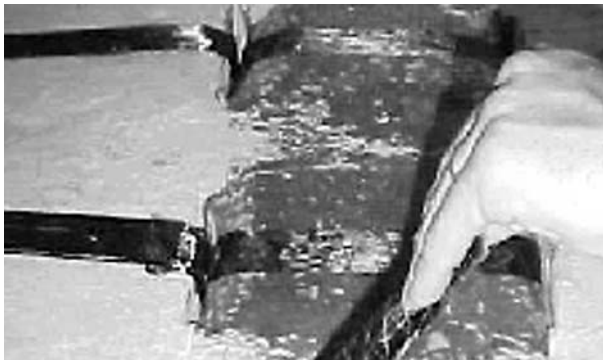
Image 25: Des rainures sont pratiquées dans la dalle comprimée du béton pour permettre un enrobage avec la C-Sheet S&P 640.
