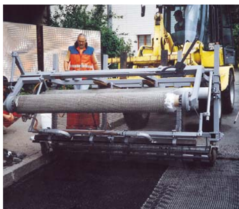
Photo 9 : Mise en place du S&P Carbophalt G
